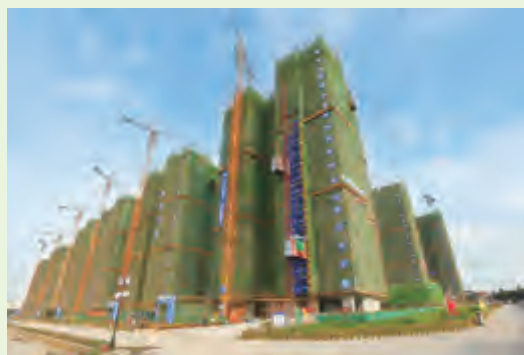
湖北襄阳樊城衡庄保障性住房项目
