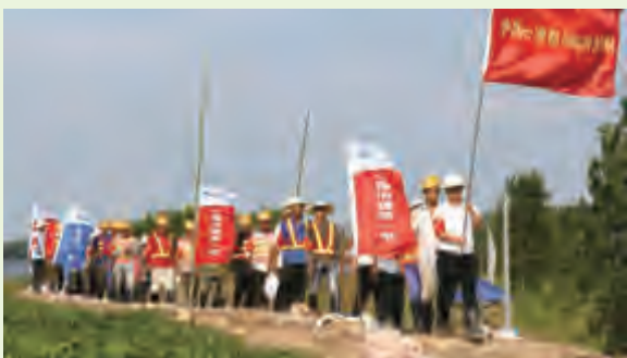
通顺河固堤抢险
