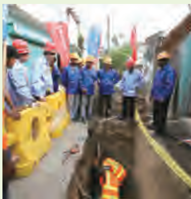
地下管网供水项目施工现场
